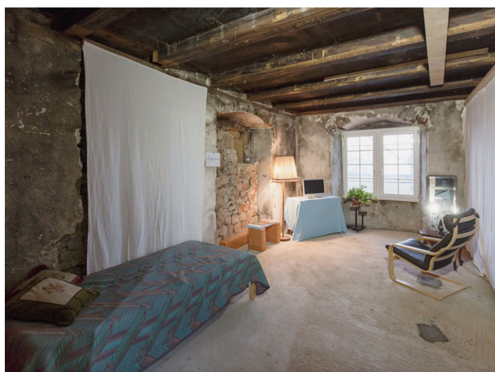
So präsentierte sich am Tag der Baustellenbesichtigung ein künftiges, aber noch unrenoviertes Zimmer. Tanja Lander
