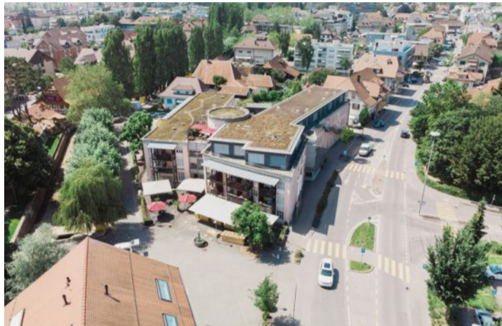
Auf der Hauptstrasse in Lyss werden auch die Leitungen ersetzt – und neu eine Fernwärmeleitung verlegt. MATTHIAS KÄSERA
